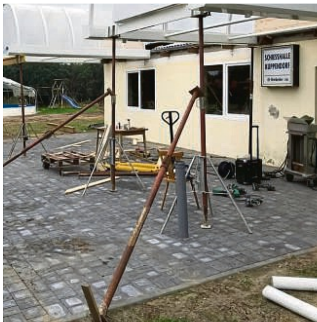
Gepflastert wurde der Eingangsbereich an der Kuppendorfer Schießhalle.
